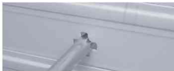
Figura 3.59. Retirando la placa metálica del slot
