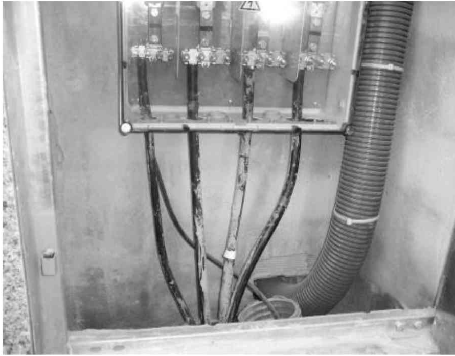
Figura 14.5. Puesta a tierra de apoyo al neutro
