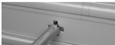
Figura 5.74. Retirada de la chapa del slot.
