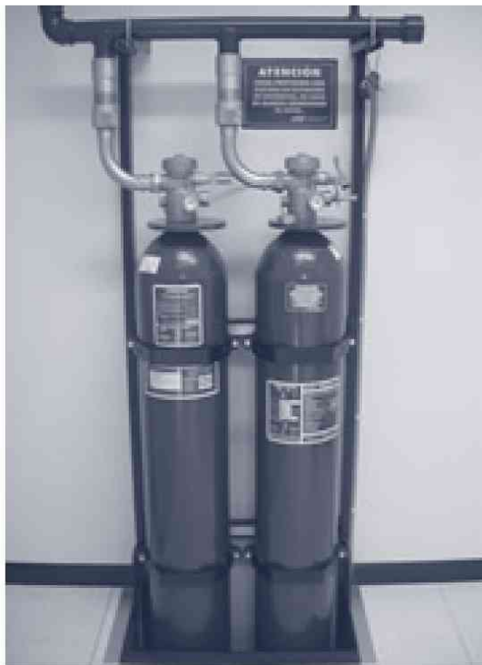
Figura 1-2. Sistema de extinción de un CPD
